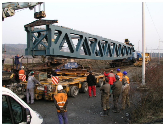
Obr. 7 Překládka jeřáby EDK 750 na vagóny
