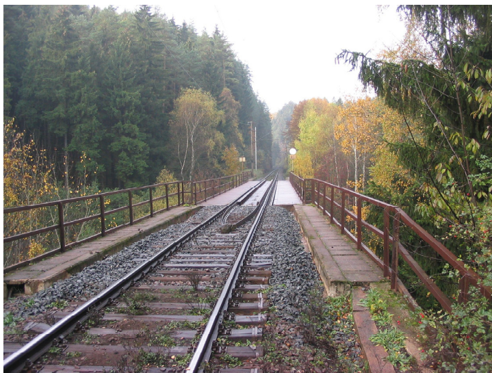
Obr. 1 Atmosféra železniční trati před stavbou
