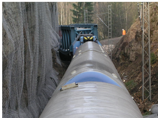
Obr. 9 Průjezd skalním zářezem
