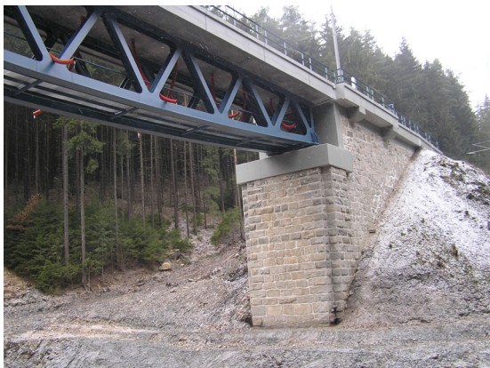
Obr. 12 SO 60-38-02 před dokončením
