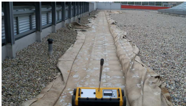
Obr 16: indukční skenování v rozkrytých korytech zatěžovací vrstvy
