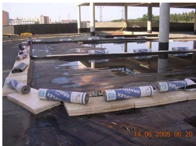
Obr 1: sektorování při zátopových zkouškách
