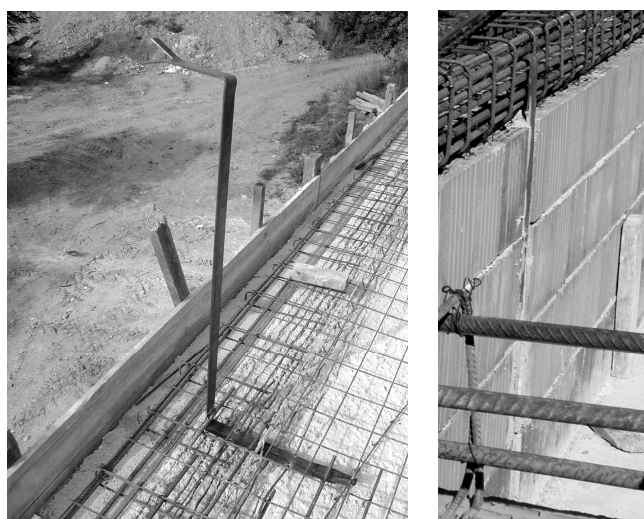
Foto 6 Vlevo - pásovina před zabetonováním, vpravo již v drážce po hraně zdiva zatažená do věnce
