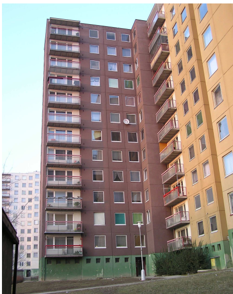
Foto č.1 a 2- bytový dům panelové soustavy B 70 – původní stav a stav po zateplení a sanaci balkónů
