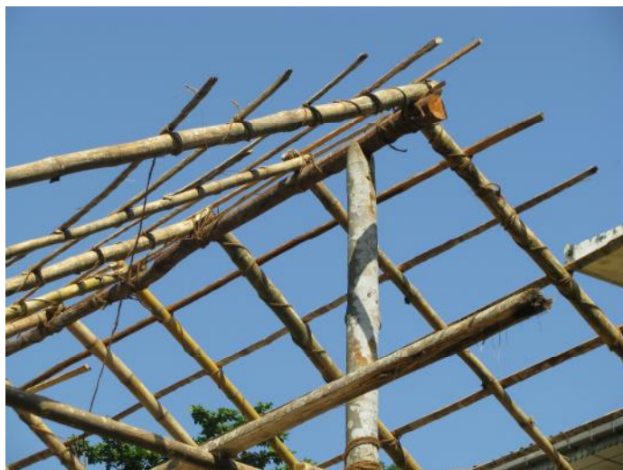
Obr. č. 11 – Hrubá stavba krovu prováděná standardním způsobem, podle hesla, co příroda dala. Tento ekologický systém velmi dobře funguje, není nutné složitě věci kupovat, stačí zajít do lesa.
