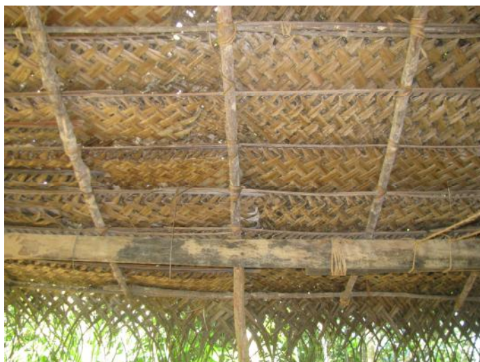
Obr. č. 12 – Konečné provedení střešního pláště z vrstevnatých tvarovek z listů kokosových palm
