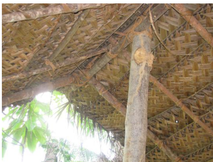
Obr. č. 13 – Konečné provedení střešního pláště z vrstevnatých tvarovek z listů kokosových palm s pohledem na sloupek a hřebenovou vaznici, vše spojováno pomocí provazů z kokosových ořechů, resp. jejich obalů.
