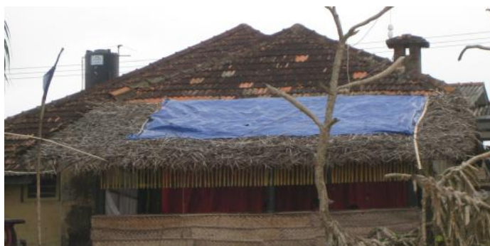
Obr. č. 16 – v některých případech musí nastoupit nová technologie, nový materiál, aby zachránil tradiční krytinu. V tomto případě byla využita moderní technologie syntetických fólií.
