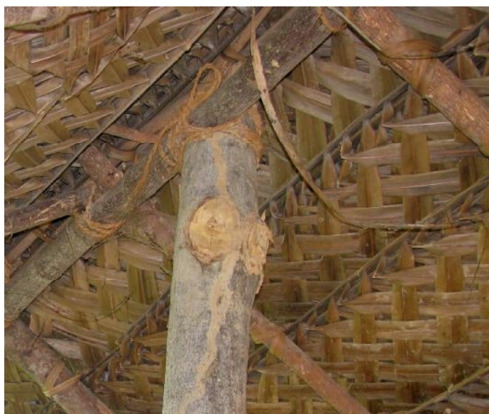
Obr. č. 10 – Použití mechanického kotvení z kokosových provazů i pro spojování prvků krovu
