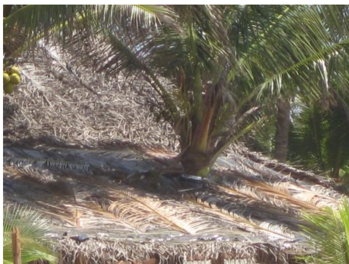
Obr. č. 15 – Detail prostupu palmy šikmou „zelenou“ střechou
