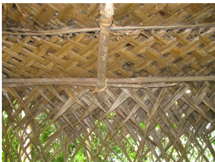
Obr. č. 8 – V některých případech tvarovky střešního pláště přecházejí ve fasádní obklad, protože na Srí Lance použití těchto materiálů a zejména kokosových palm má absolutně univerzální použití.
