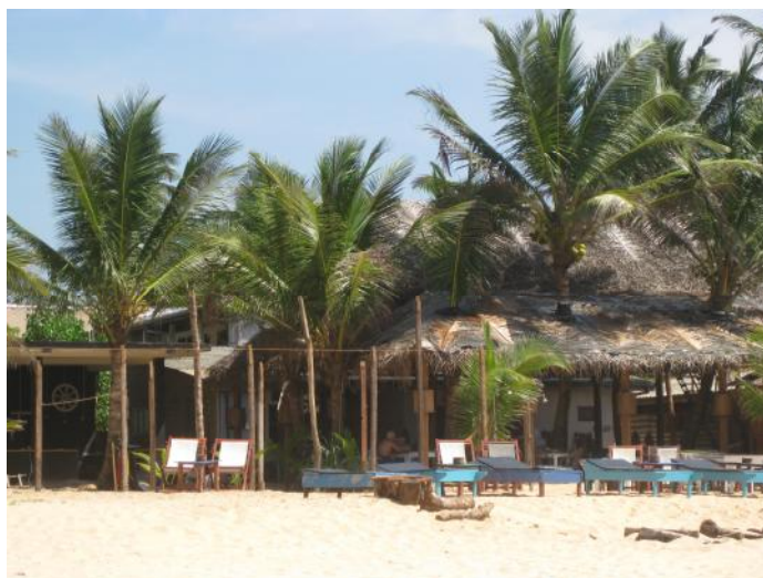
Obr. č. 14 - Celkový pohled na objekt krytý střechou z palmových tvarovek
