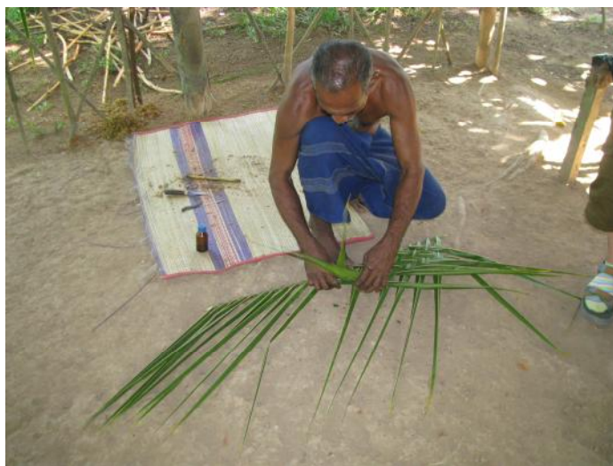
Obr. č. 1 – Postup výroby tvarovek pro šikmý střešní plášť z kokosových listů
