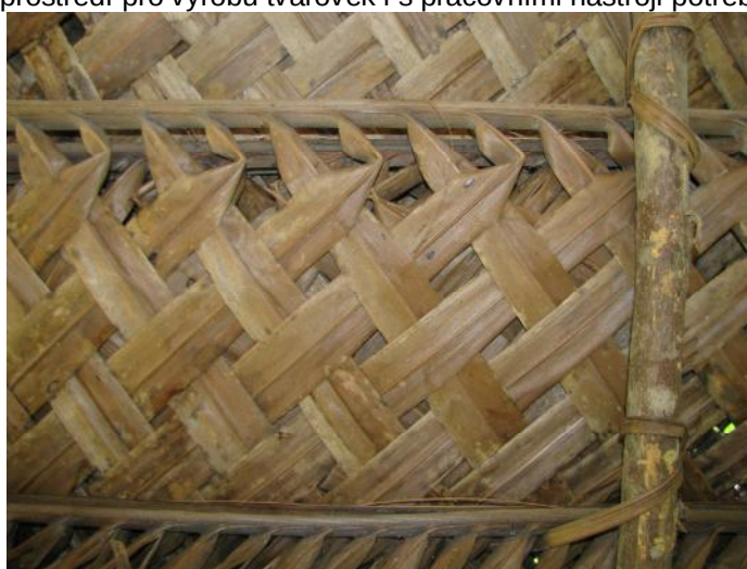
Obr. č. 7 – Výsledné výrobky, tvarovky z kokosových listů jsou položeny na konstrukci krovu
