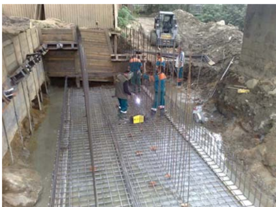
Obr. 7 Výstavba opěry pod MP
