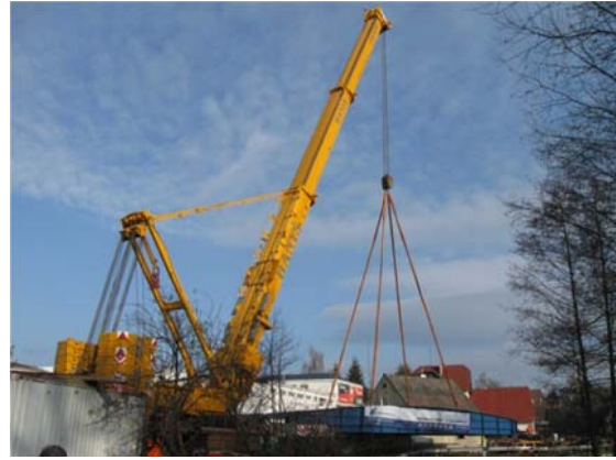
Obr. 12 Ukládání NK mostu na opěry
