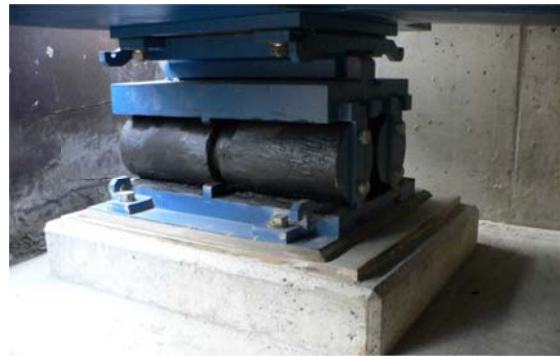
Obr. 14 Ocelové dvouválcové ložisko 2VS-3
