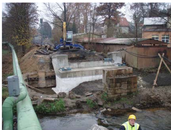
Obr. 8 Nová opěra vs. původní pilíř
