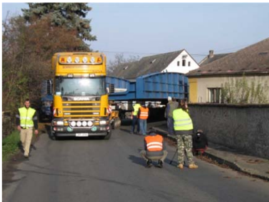
Obr. 9 Vypravení NK mostu z mostárny
