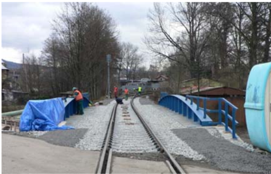
Obr. 13 Železniční svršek na mostě
