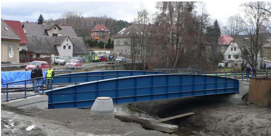
Obr. 15 Téměř dokončený most
