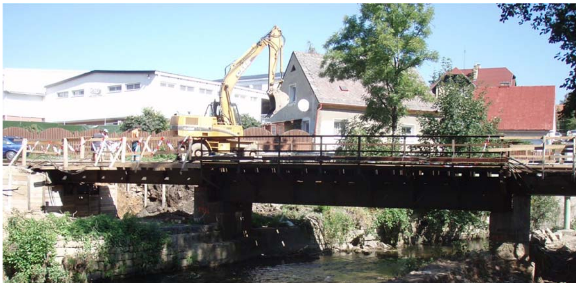
Obr. 6 Mostní provizoria v krajních polích
