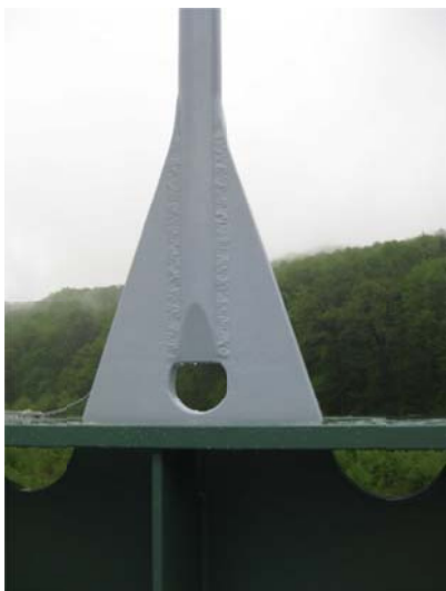
Obr. 4 Detail napojení táhla na trám
