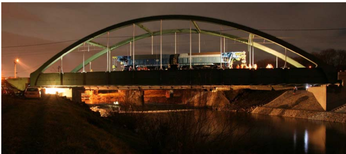
Obr. 7 Pohled na most při zatěžovací zkoušce
