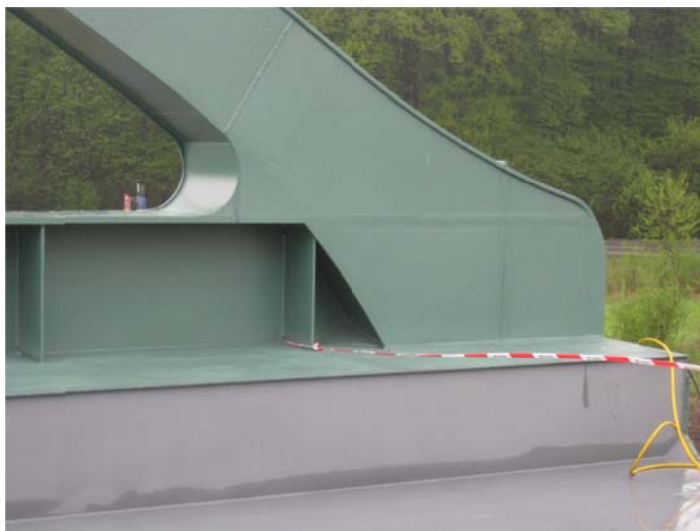
Obr. 5 Napojení oblouku na trám
