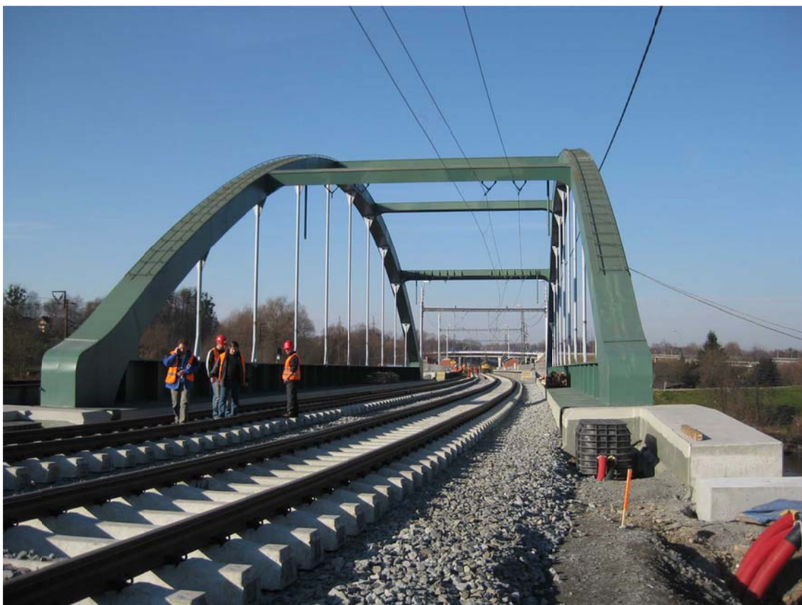
Obr. 8 Pohled do mostu těsně před dokončením
