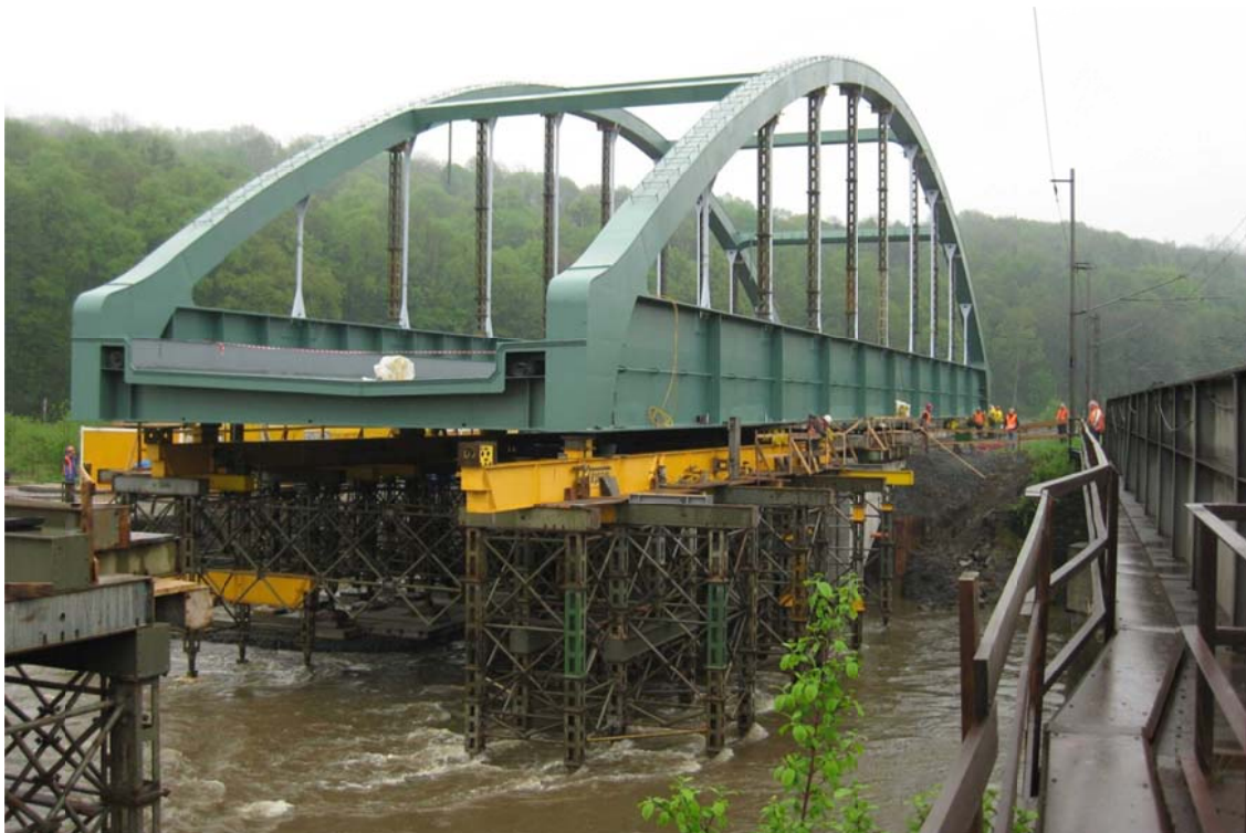
Obr. 6 Výsun OK nad rozvodněnou řekou
