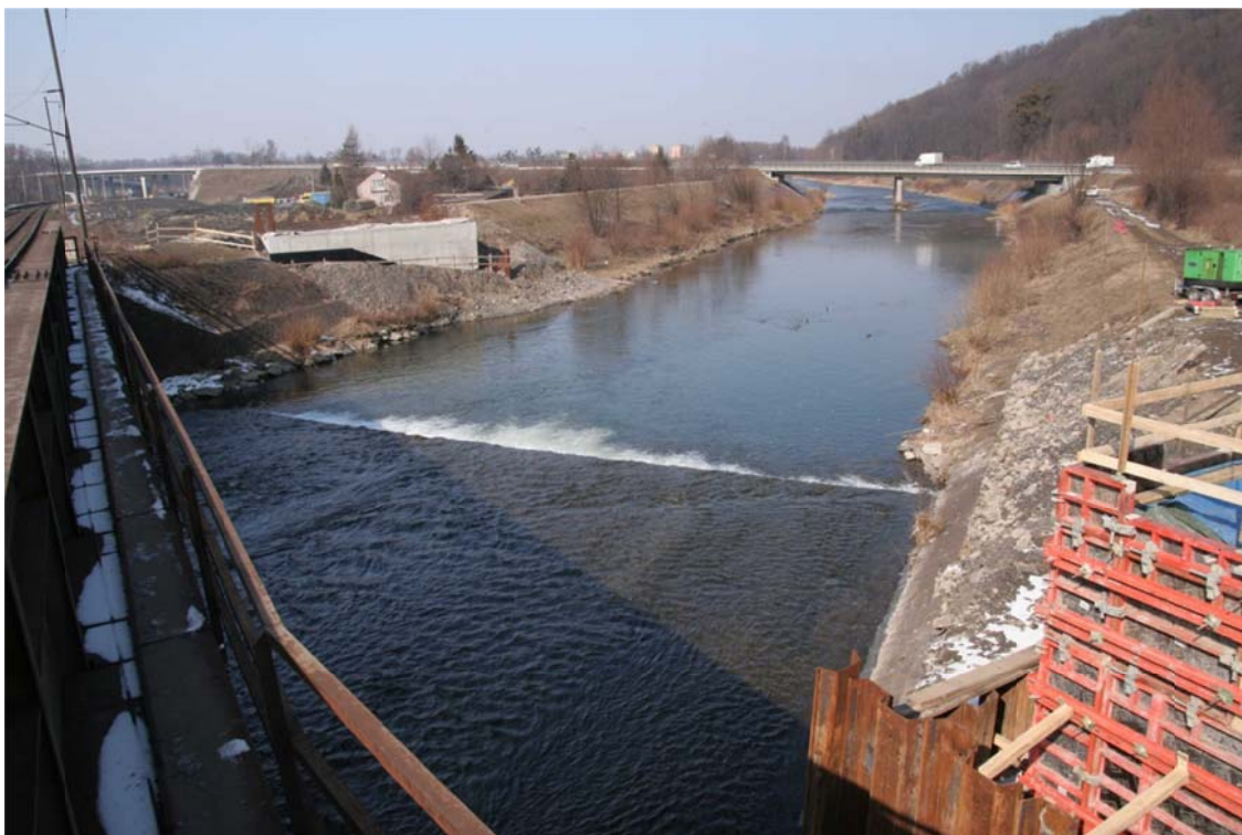
Obr. 2 Pohled na opěru z původního mostu
