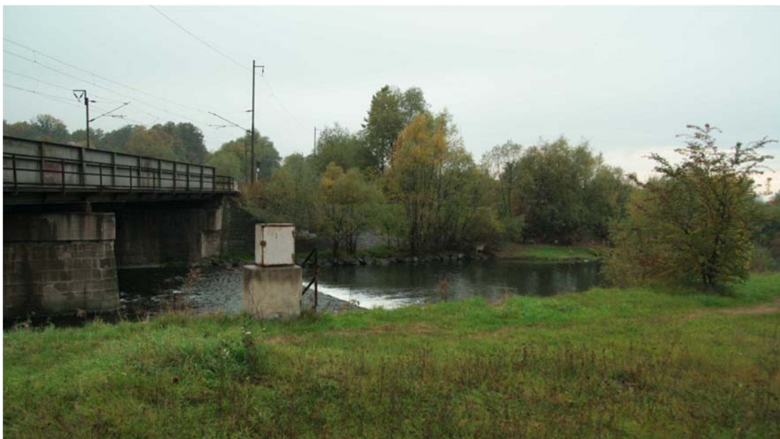
Obr. 1 Místo stavby, vlevo původní most
