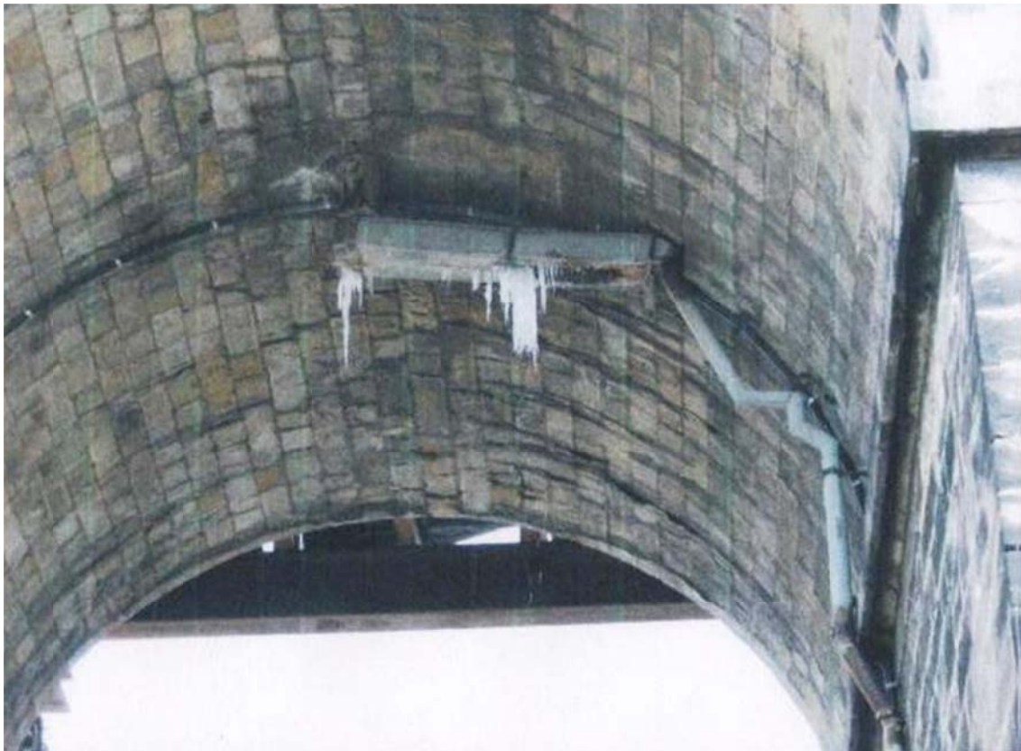
Obr. 7 Stav odvodnění mostu před rekonstrukcí
