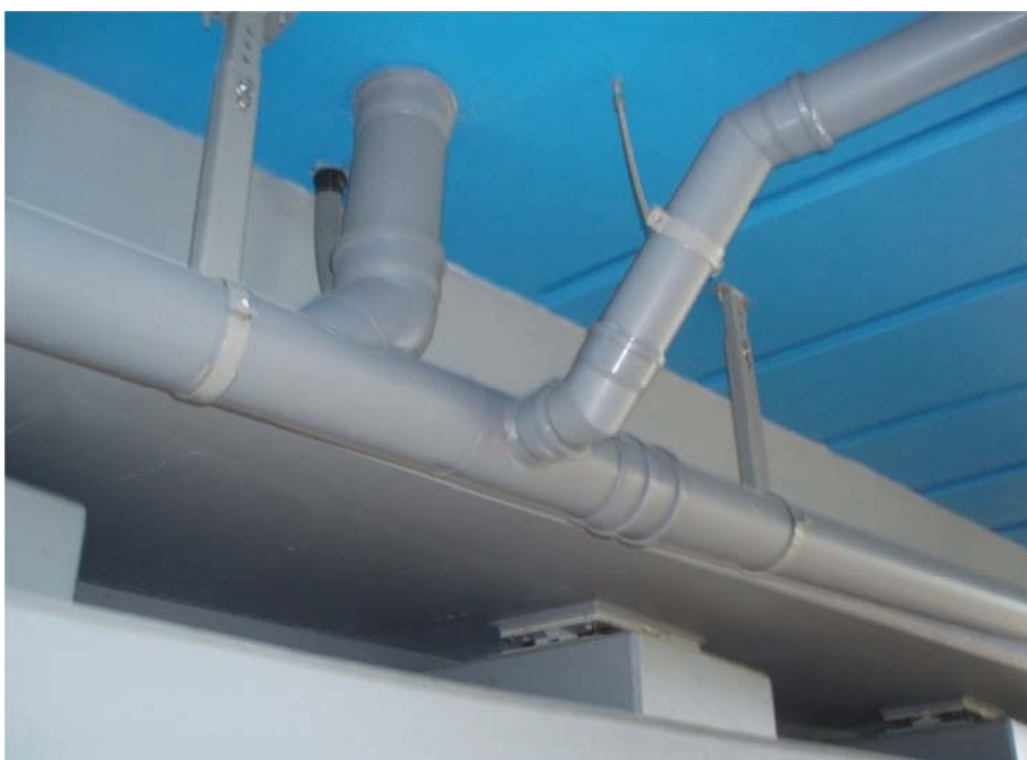
Obr. 10 Univerzálnost a variabilitnost potrubí PP s kompenzačním hrdlem bez spojek
