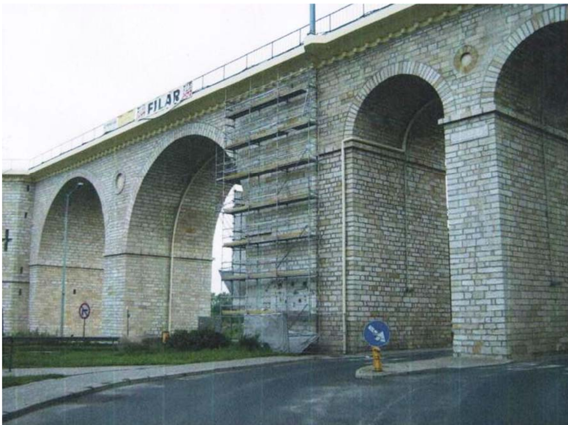
Obr. 8 Stav odvodnění mostu po rekonstrukci
