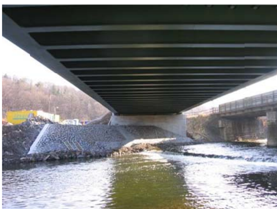
Obr. 9 Pohled na bystřickou opěru
