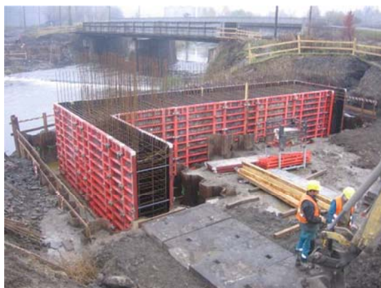
Obr. 2 Bednění dřívků opěr
