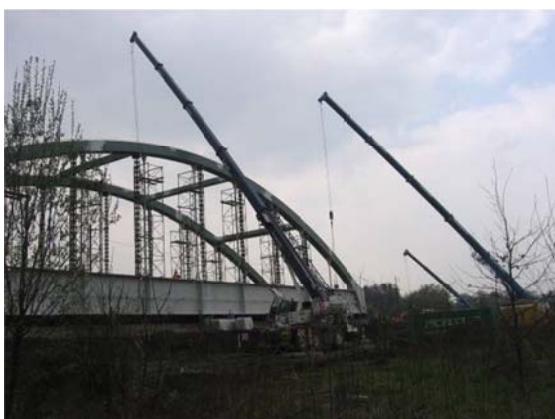
Obr. 3 Montáž OK mostu
