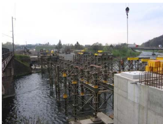
Obr. 4 Montáž vysouvací dráhy
