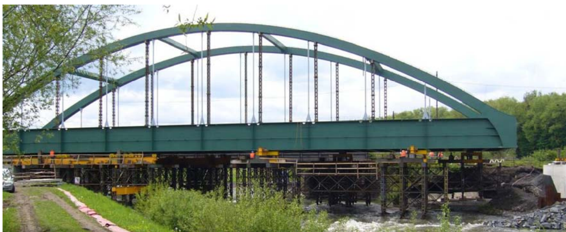
Obr. 6 Výsun konstrukce
