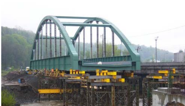
Obr. 7 Výsun konstrukce
