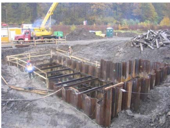
Obr. 1 Štětové jámky pro založení opěr
